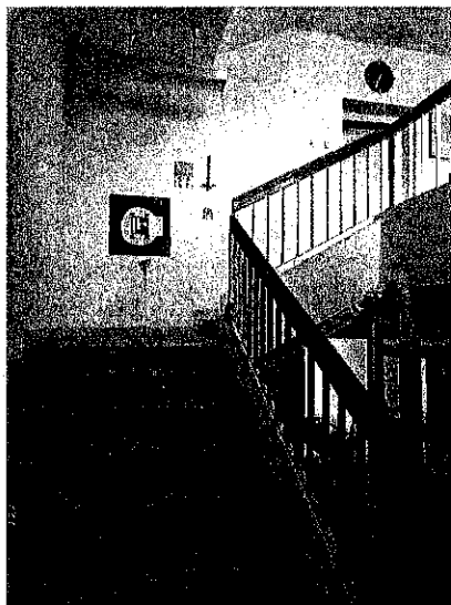
1.poschodie pred upravami
